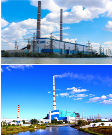
Сурет 2 – Екібастұз ГРЭС-2 – Екібастұз қаласындағы электр станциясы
